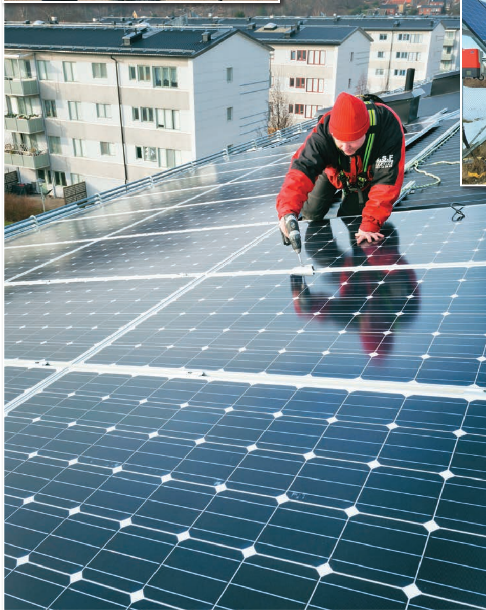
Lắp đặt tấm pin năng lượng mặt trời
