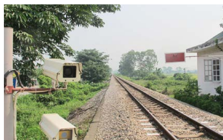
Đề tài lắp radar phát hiện chướng ngại trên đường ngang, tự động xử lý tín hiệu ngăn tai nạn
