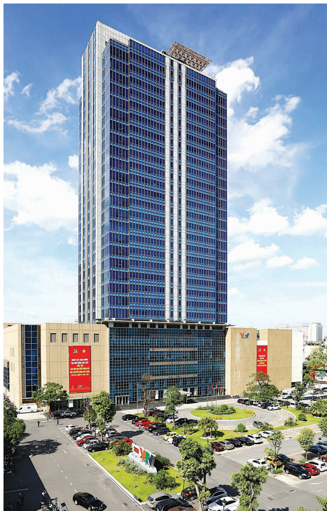
Tòa nhà trung tâm Đài THVN hiện nay The current VTV central building
