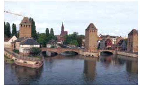
Cầu đập Vauban với 3 ngọn tháp cổ
